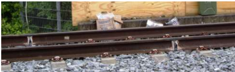
To nyudførte thermitsvejsninger (med restaffaldet i baggrunden)
